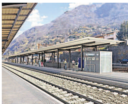
ACCESSI Le scale del sottopasso che portano al binario 3 verranno allargate; prevista anche la posa di un lift. (Foto FFS)
