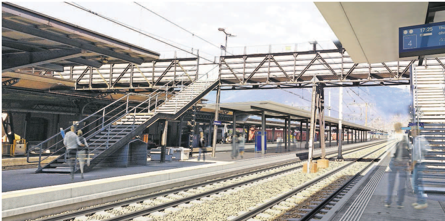
INTERVENTI Marciapiedi, pensiline e sottopassi verranno adattati all'aumento di viaggiatori atteso già a partire dalla fine dell'anno prossimo. (Foto FFS)
