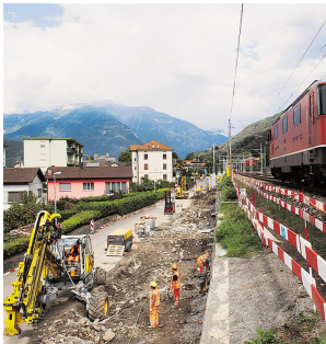
PIENA ATTIVITÀ I lavori per la posa del terzo binario e per il completamento dei ripari fonici sono iniziati lo scorso mese di luglio. (Foto Crinari)
