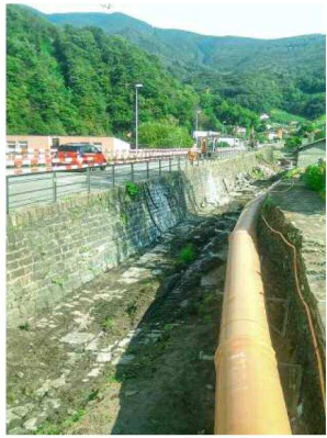
Il cantiere è entrato nel vivo
