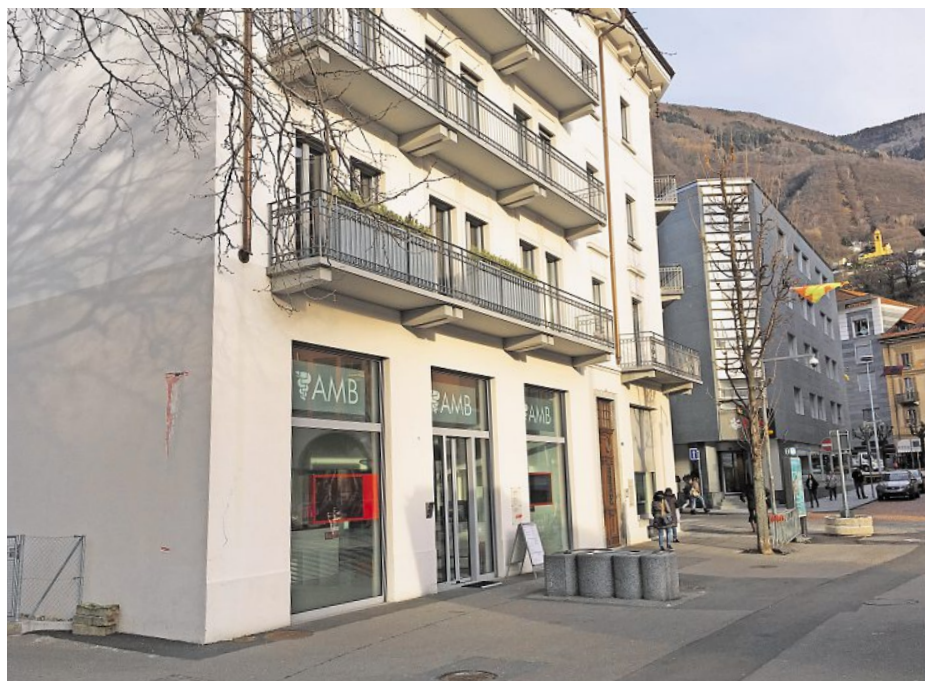
UN ESEMPIO In alto il complesso ex Rondi in piazza del Sole nella situazione protrattasi per anni prima della ristrutturazione. Qui sopra come si presenta oggi, con rinnovati spazi residenziali e amministrativi. (Foto CdT e Archivio CdT)
